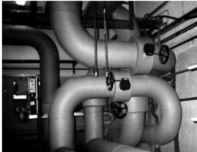
Рис. 31. Сегментная изоляция и вспененного стекла
