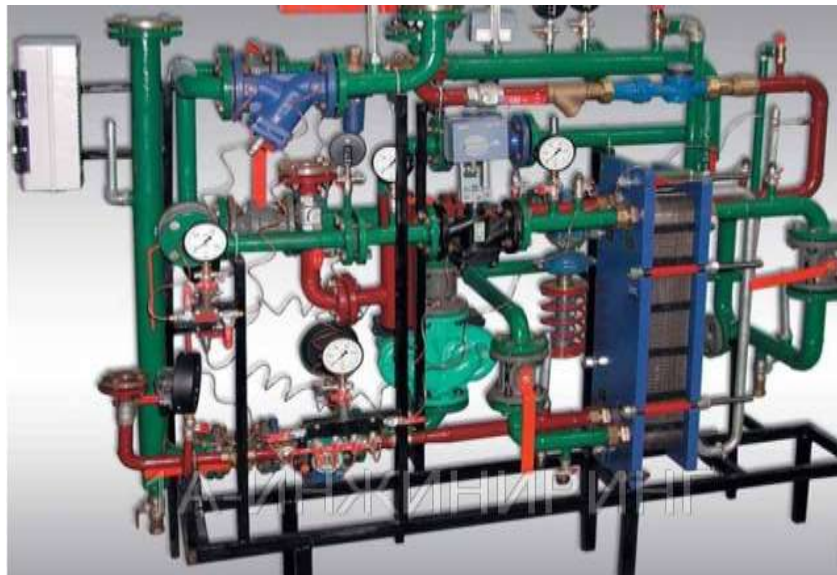
Рис. 6. Индивидуальный тепловой пункт (ИТП)
